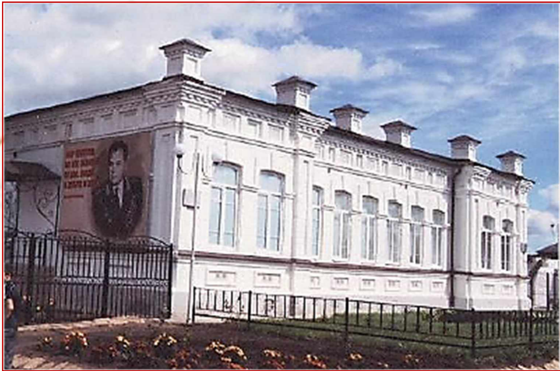
Здание Муниципального автономного учреждения «Культурный центр имени дважды Героя Советского Союза Г.А. Речкалова». Общий вид. Снимок № 1. пос. Зайково. 15 августа 2015 г. ГКУСО «ГА в г. Ирбите». Ф. К-1. Оп. 5ф. Д. 600п.
